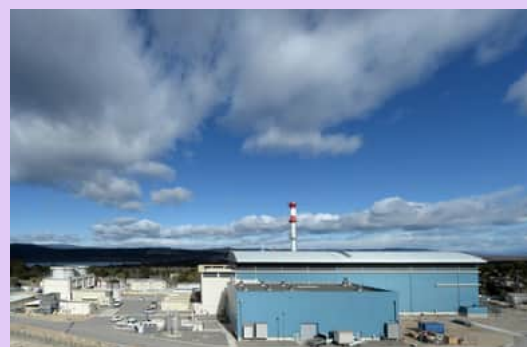
Le bâtiment du RES à Cadarache.
